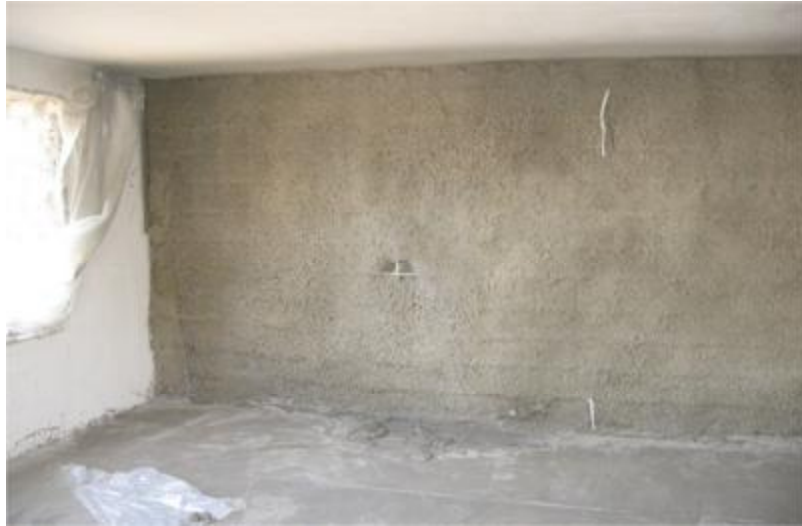
Рис. 5. Несущая стена после проведения восстановительных торкрет-работ
