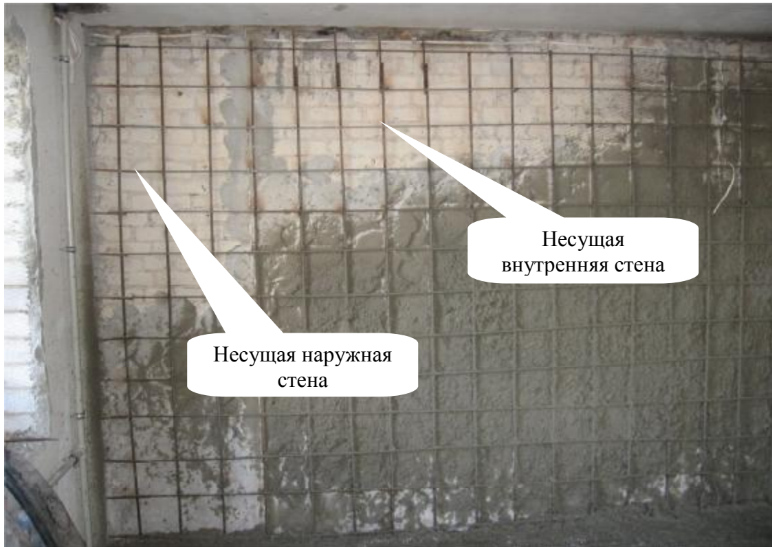
Рис. 2. Усиление стен за счёт применения дополнительного армирования
