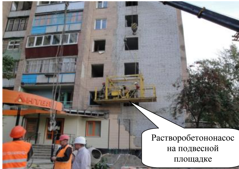
Рис. 3а. Растворобетононасос на подвесной площадке
