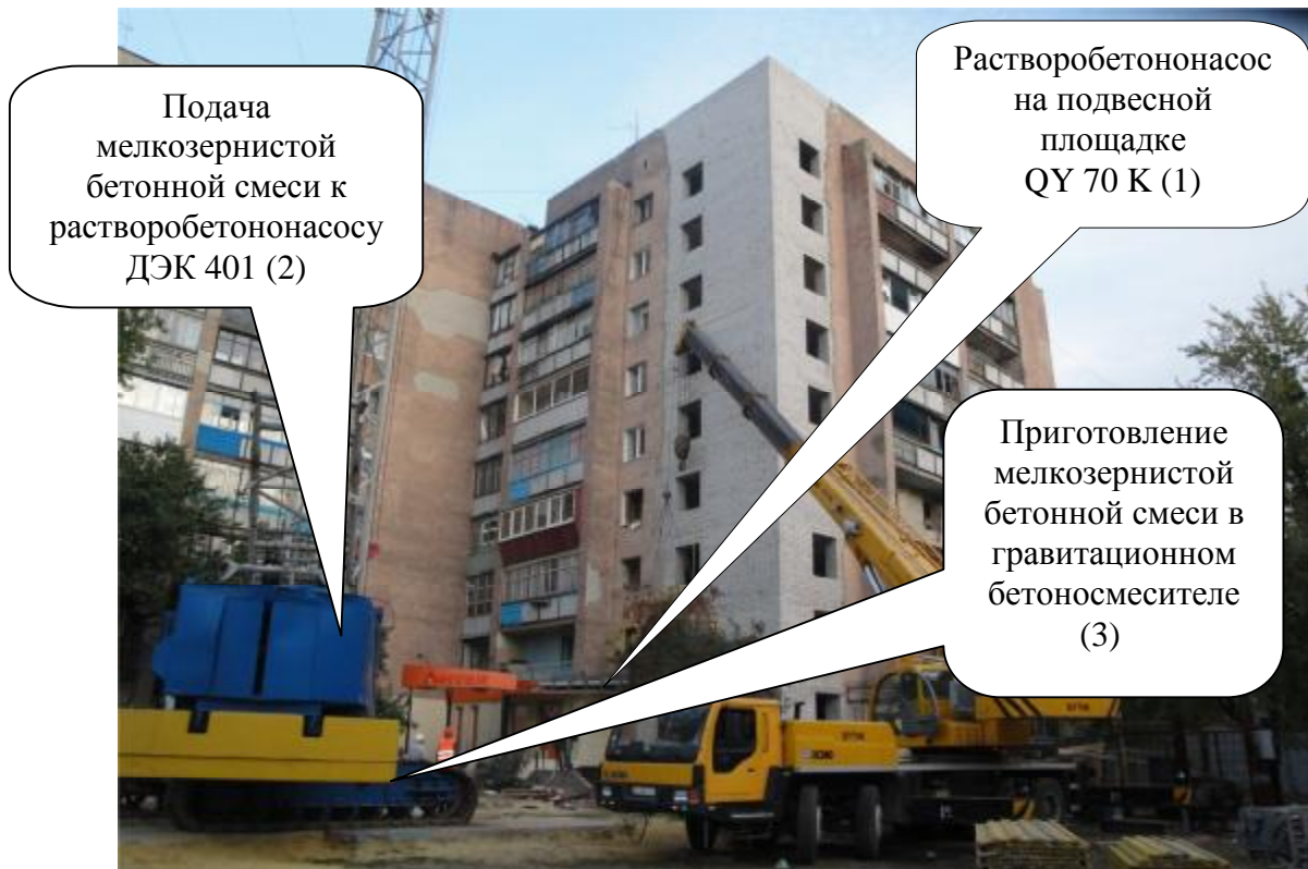
Рис. 3. Технологическая схема использования двухпоршневого растворобетононасоса
