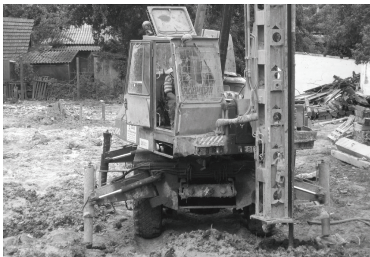
Рисунок 3 – Процес виготовлення ґрунтоцементної палі за бурозмішувальною технологією
