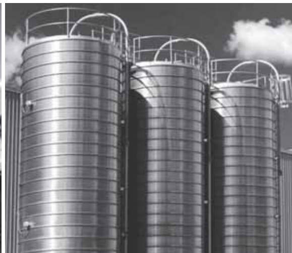
Рис. 2 – Види вертикальних металевих силосів: а – прямокутний зі сталевих гофрованих панелей; б – прямокутний із гладких панелей; в – із плоским дном; г – з конусним дном; д – круглий із гофрованих панелей на болтових з'єднаннях; е – круглий із гладких панелей на болтових з'єднаннях; ж – спіральньо-фальцевий силос
