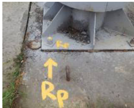
Рисунок 11 – Приклад закріплення постійного репера
